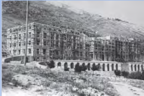
C.S.S. in costruzione – 1947/56
